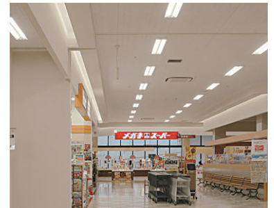
共用通路天井壁面は32WHf蛍光灯トラフを使用した間接照明により空間に広がり感を演出
