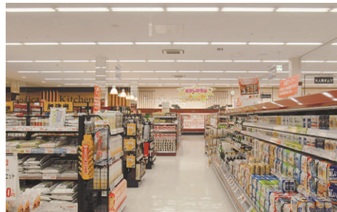
正面から売場奥の照明を望む 昼白色の薄形直付器具の連結配置により売場に明るくライン光が得られている
