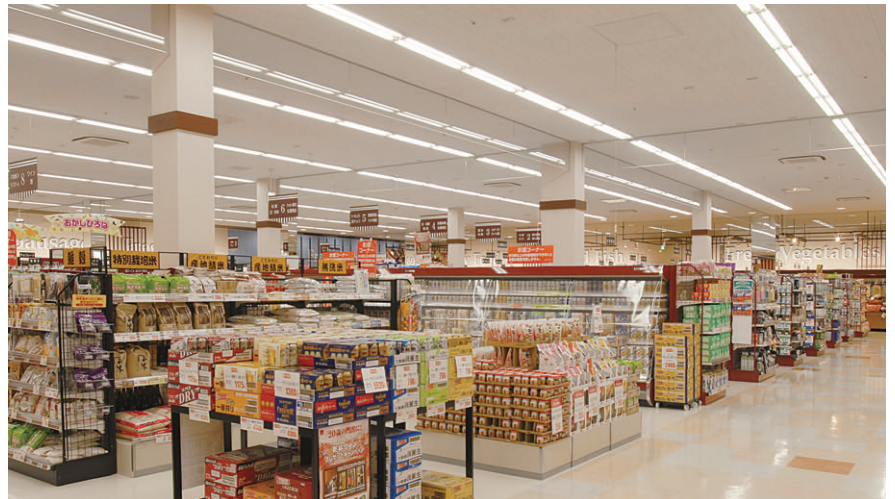
食品館売場のベース照明 32WHf蛍光灯2灯用薄形直付器具で、器具幅も細くしてスッキリした天井を形成。商品がわかりやすく、選びやすい光環境を創出
