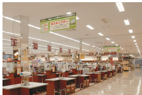
共用通路のベース照明 昼白色の薄形直付器具を整列配置、和みのある雰囲気を創出
